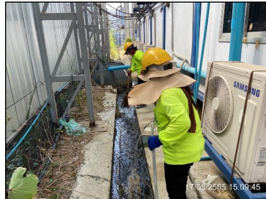
ภาพที่ 30 ขุดลอกรางระบายน้ำ
