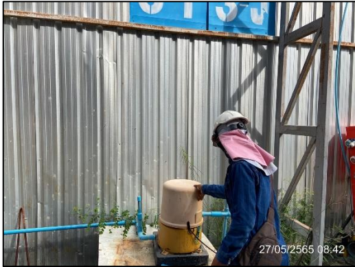
ภาพที่ 62 ตรวจสอบการรั่วซึมของเส้นท่อประปา
