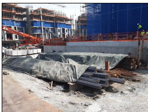
ภาพที่ 9 ใช้ผ้าใบปิดคลุมวัสดุก่อสร้าง
