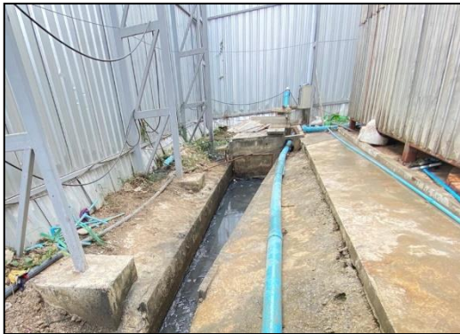
ภาพที่ 29 ตะแกรงดักขยะ
